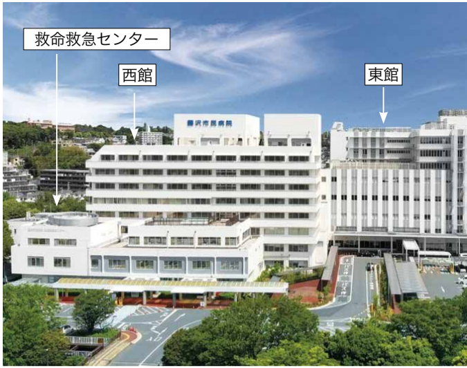
主要機能を有する西館と救命救急センターの早期更新が求められる
