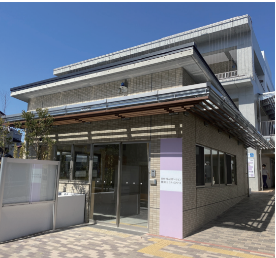
4月に新設の藤沢東部地区の安全・安心ステーション
