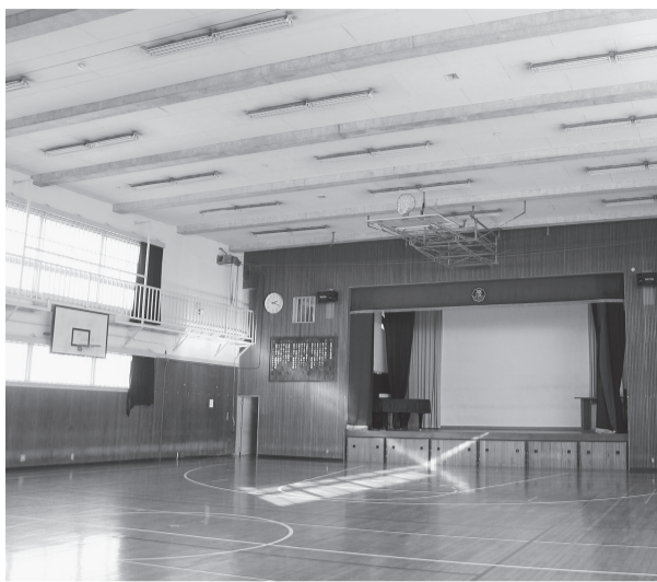
天井や照明器具等の非構造部材の耐震化を進める
