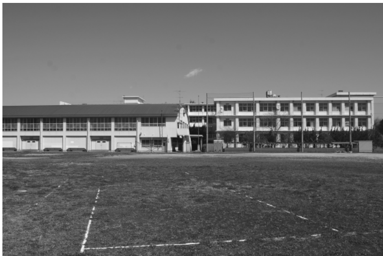
跡地の有効活用が望まれる元県立藤沢高等学校
