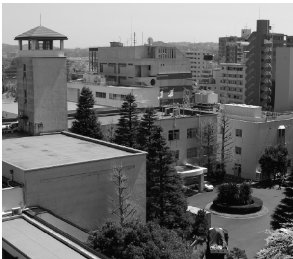
喫緊の課題となっている市役所本館・東館の建て替え
