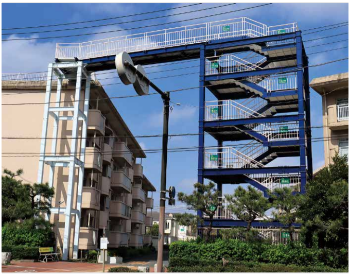
沿岸3地区や庁内関係各課と連携し、新たな津波避難ビル確保を図る
