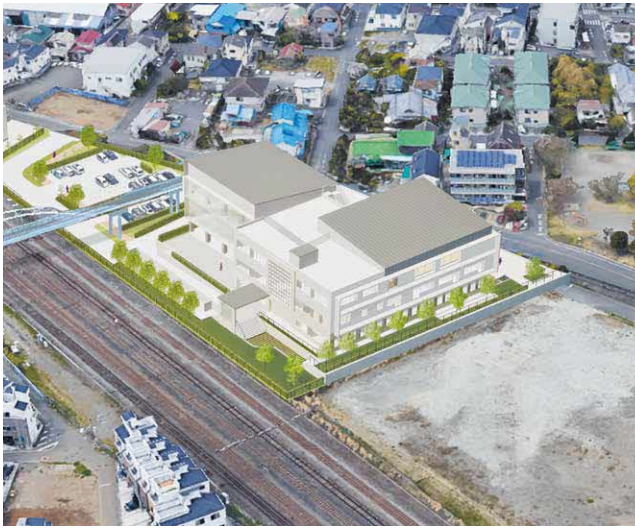
再整備が予定されている村岡公民館
