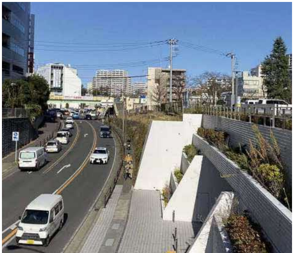
外壁の一部を解体し、歩道を拡幅する = 市役所本庁舎前
