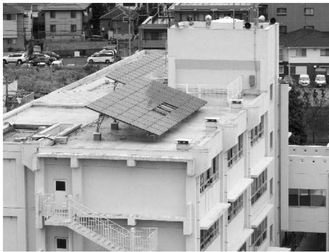
災害時も電源となる太陽光発電システム=大道小学校
