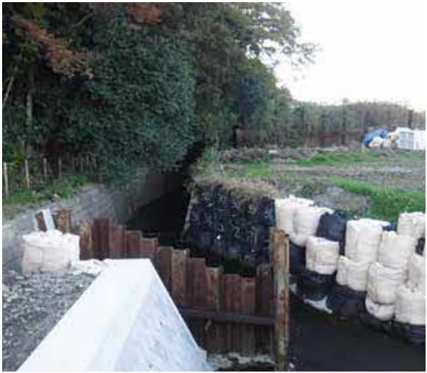
治水対策等で温暖化の災害に備える＝一色川護岸改修工事
