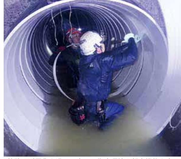
管路の耐震化を進め、市民の衛生環境や都市機能を守る
