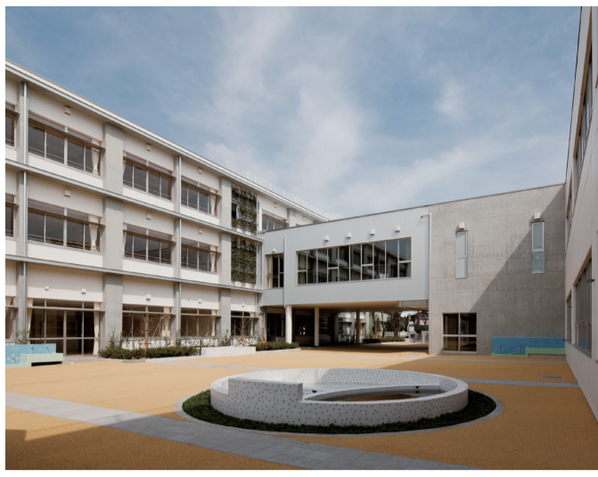
平成23年度に校舎棟を改築した本町小学校
