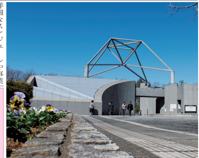
現在の立体墓地の西側に新たな建物の建設を計画する=大庭台墓園
