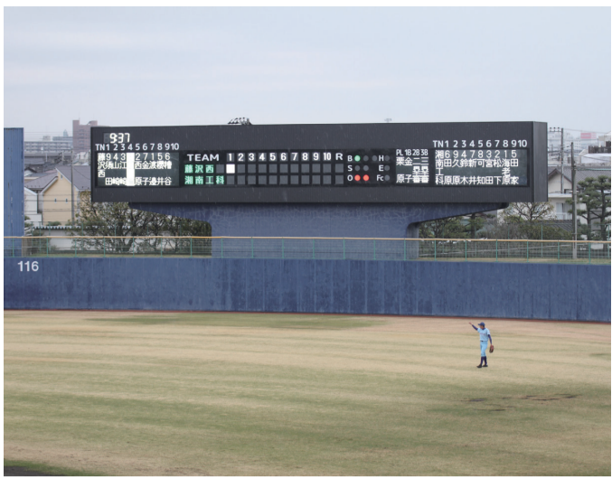
改修されたスコアボード=八部公園野球場
