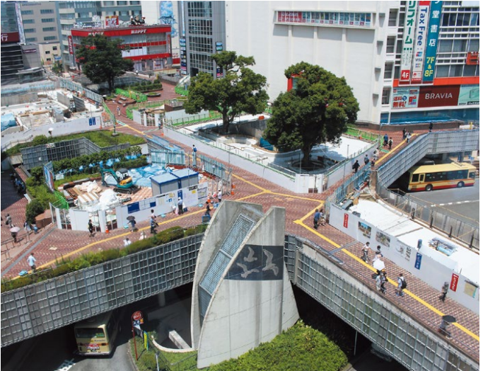
エリアマネジメント導入に先行して再整備工事が進められる北口デッキ
