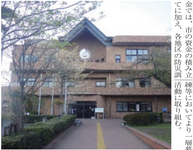
福祉避難所が開設される各地区の市民センター
