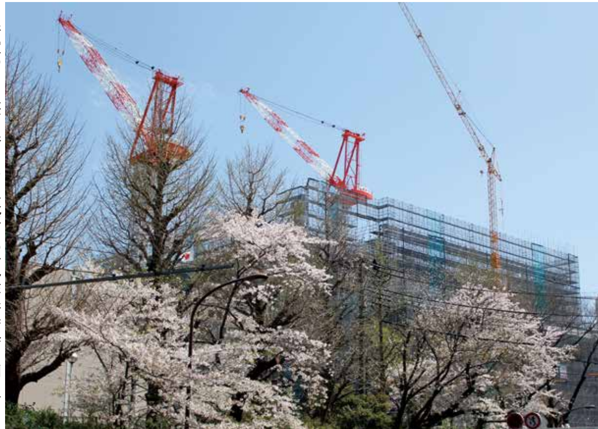
青空のもと桜に彩られた建設中の市役所新庁舎Ⅱ朝日町
