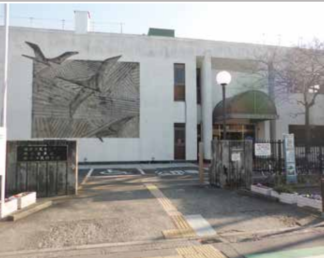
再整備が検討されている鶴沼市民センター
