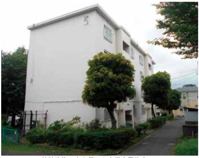
外壁改修工事を行った市営古里住宅
