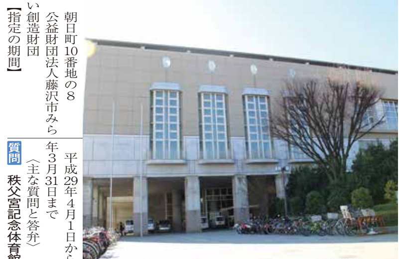
補修工事が予定されている秩父宮記念体育館
