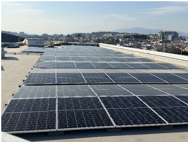
第一中学校屋上
