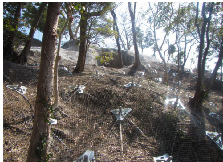
施工例：令和3年度御所ヶ谷緑地法面对策工事
