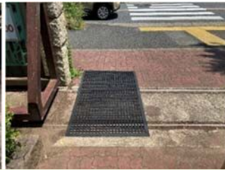
正門のレールにベビーカー用の段差解消通路設置
