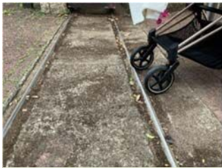
正門のレールにベビーカー用の段差解消通路設置
