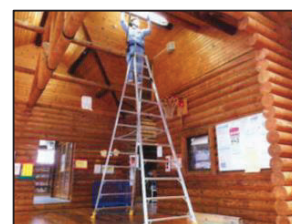
業者による修繕
