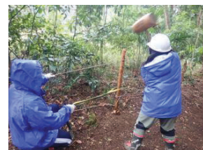
職員による散策路杭修繕
