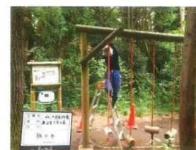
専門業者による修繕
