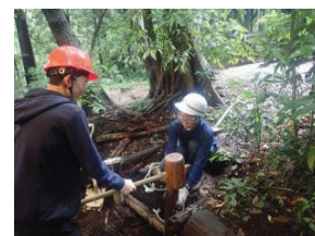
職員による軽微修繕
