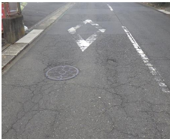
舗装破損状況
