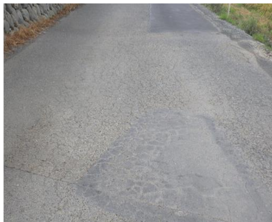
舗装破損状況
