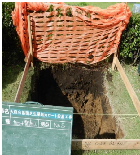
カロート工事 例
