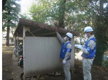
外構・附属施設の点検
