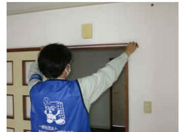
空き住戸修繕の調査
