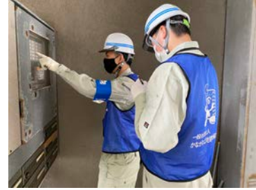
附帯施設の点検
