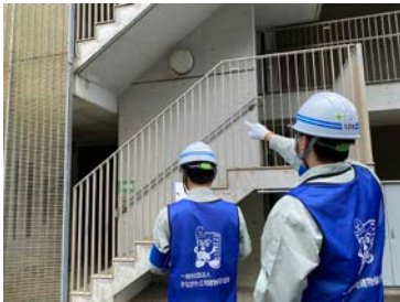
外壁等剥落有無の点検
