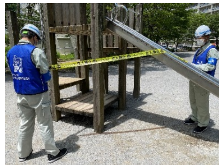
立入禁止の応急措置
