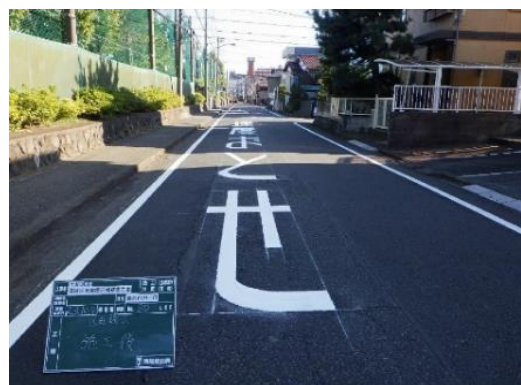
道路区画線標示設置
