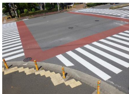
道路区画線標示設置（カラー舗装）
