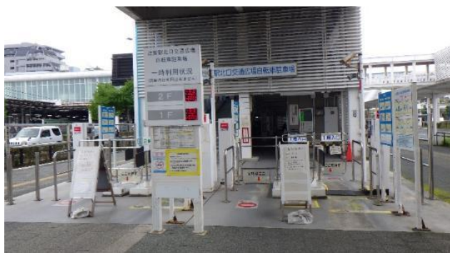
辻堂駅北口交通広場自転車駐車場
