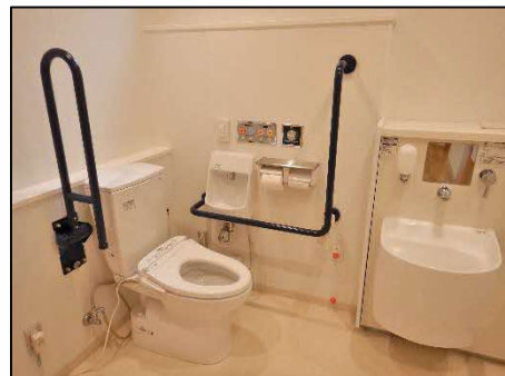
多目的トイレ
