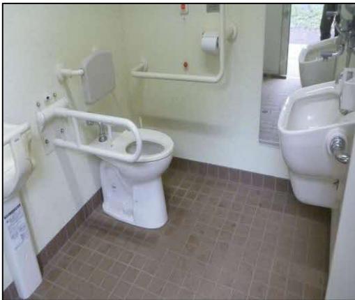
多目的トイレの設置
