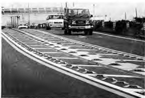
暴走族対策としてのキャプターバーを設置（国道134号線）
