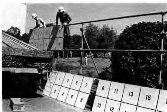
公営選挙ポスター掲示場の設置作業
