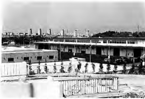
完成した中央卸売市場（昭和56年4月2日開場）
