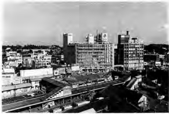
スタートした藤沢駅北口再開発
