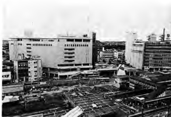
完成間近の北口再開発ビル（手前は駅舎改造が進む国鉄藤沢駅）
