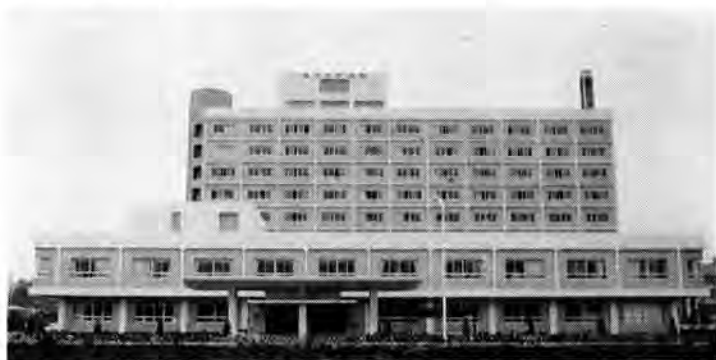
10月1日に開院した藤沢市民病院
