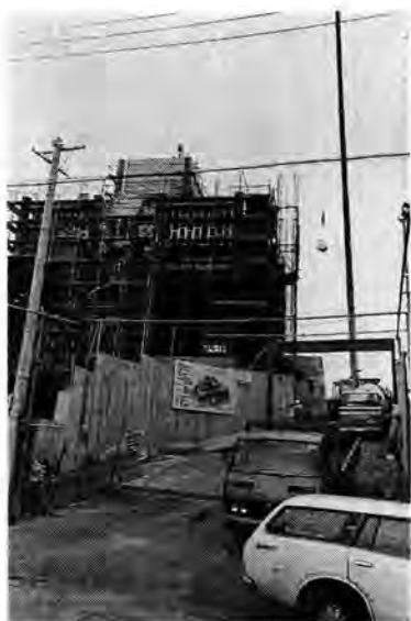
建設中の労働会館
