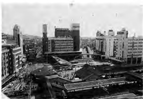
藤沢駅南口広場に設置された仮設歩道橋
