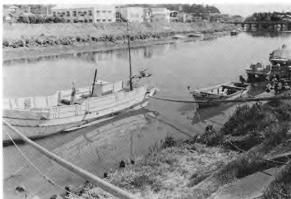
都市化で改修が必要な境川 （西浜橋付近）
