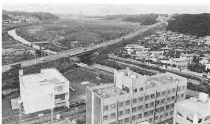
用地取得した六漥水地区下水処理場用地 （藤沢バイパス北側の空地が建設予定地）市4.12
