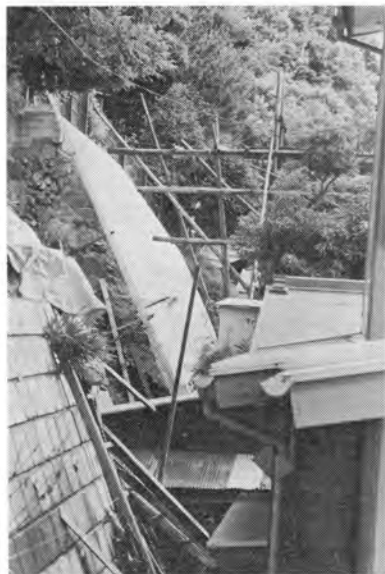
水害・がけくずれ対策で擁壁工事中の急傾斜地（藤沢地区）
