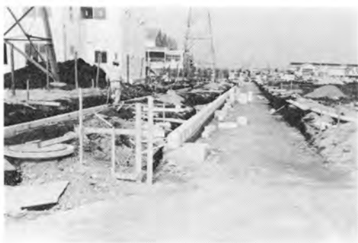
ほぼ完了した北部第一土地区画整理 事業（区域内の街路工事）
