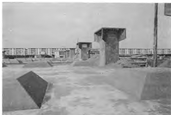
南部下水処理場第3系列最初沈 澱池工事に着手 市6.この月
