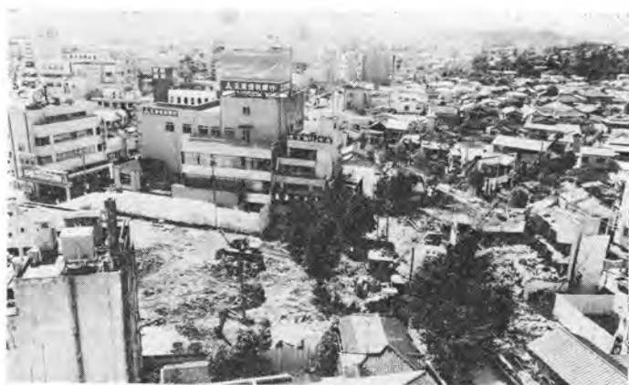
藤沢駅北口市街地再開発事業で既存建物取り壊し工事に着手 市6.9
