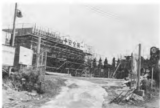
〈仮称〉辻堂市民センター新設工事に 着手 市1.12 6.15
