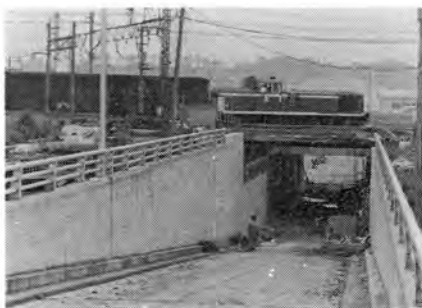
国鉄小塚踏切立体化工事の現場 （村岡地区）議2.27〔議141〕
