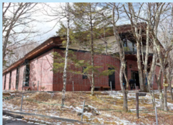
施設内の設備や修繕箇所などを視察
