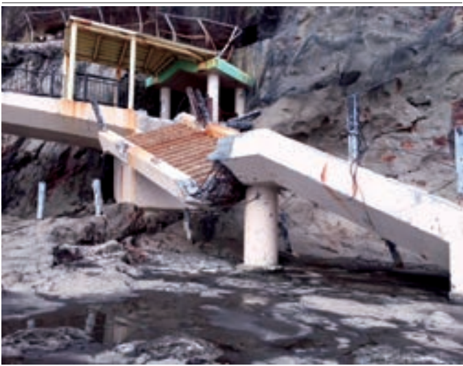
大規模に崩落した江の島岩屋の第二階段
