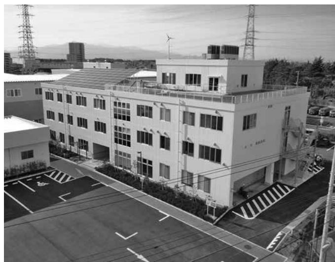
公共施設等での太陽光発電により、電力の地産地消を図る＝リサイクルプラザ藤沢
