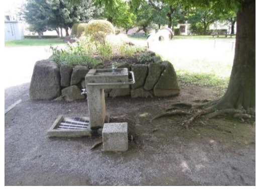
水飲み場 水飲み場は手すりが設置されているが、車椅子の利用時に木の根が支障となっている。
