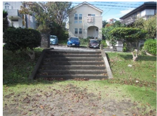
階段 階段に手すりが設置されていない。
