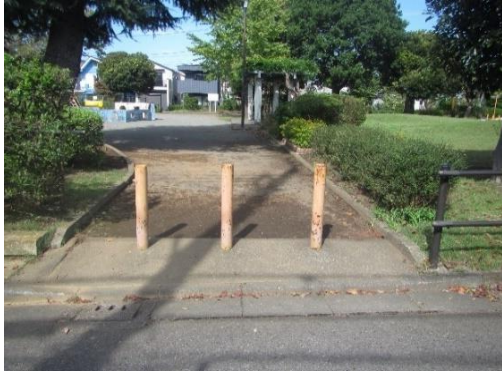
出入口 出入口に段差があり、通行に必要な幅が確保されていない。
