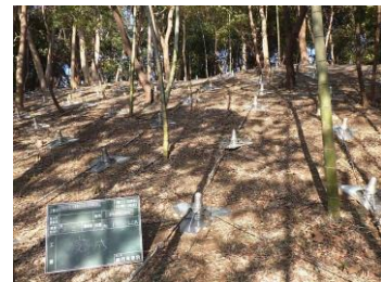
< 法面对策工事の事例 >
