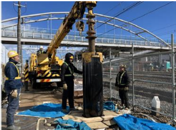
□電柱基礎杭打設工事
