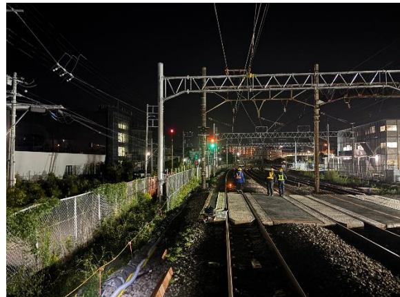
□信号設備設置
