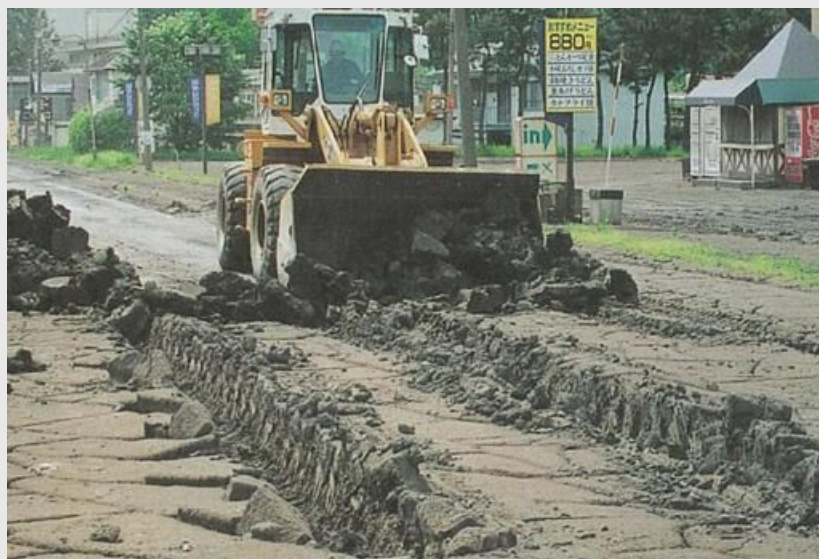
2000 年 6 月有珠山の噴火により降り積もった灰を取り除く重機（北海道旧虻田町（現洞爺湖町）） [資料：大規模噴火時の広域降灰対策について -首都圏における降灰の影響と対策-（令和 2 年 4 月）]
