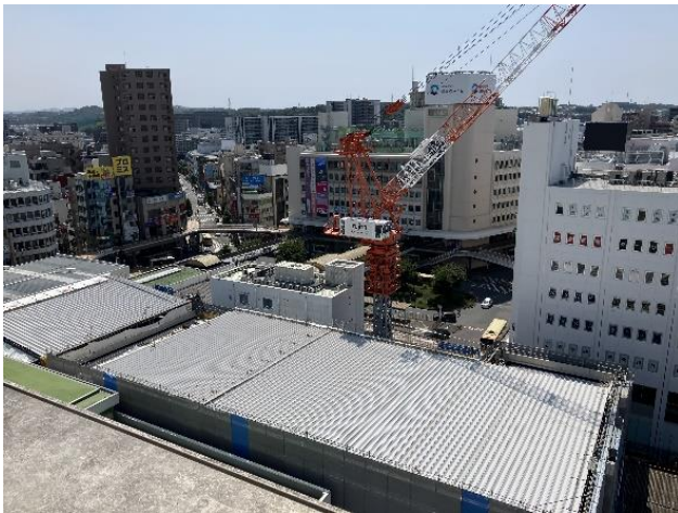
図2 施工状況（橋上駅舎上空）
