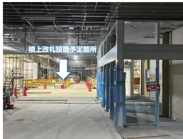
図3 施工状況（橋上駅舎内）
