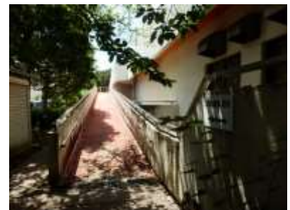
③ 本館2階へアプローチする斜路
