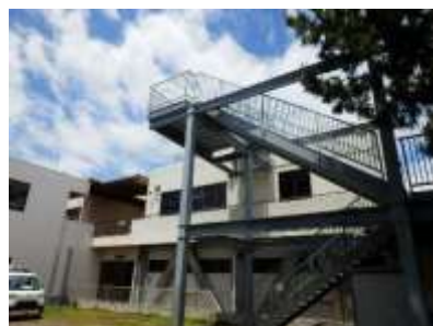
④ 新館建物と屋上への津波避難階段
