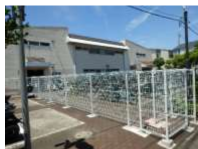
⑦ 鉄骨造2階建ての自転車等駐車場
