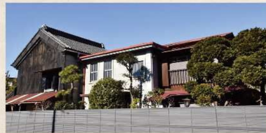
主屋 東側外観
