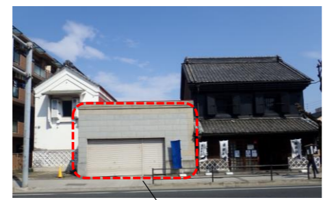
増築倉庫は解体します
