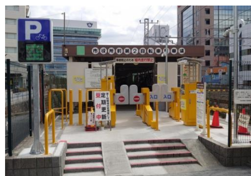
機械化による利便性の向上
