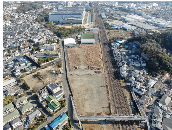
上空から見た村岡新駅周辺地区
