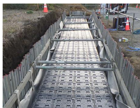
写真 葛原第1工区の令和4年度施工箇所 （雨水貯留施設設置状況）
