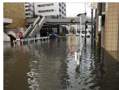
【内水浸水状況】 奥田公園前交差点 2019（令和元）年 12 月
