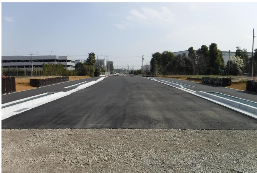
写真1 葛原第1工区の令和3年度施工箇所 （新産業の森地区を望む）
