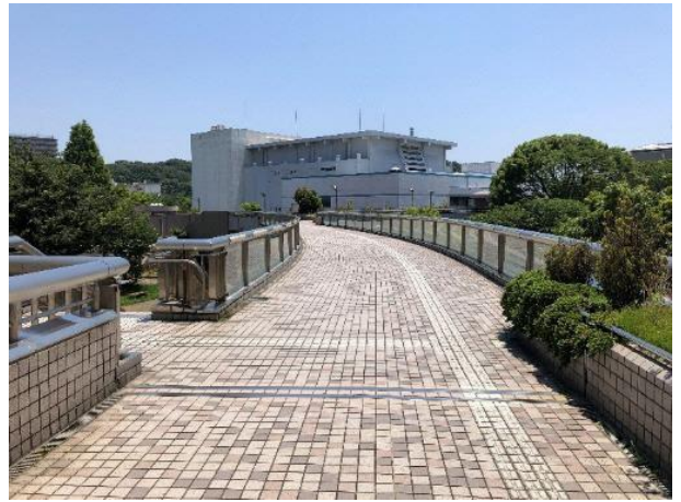
②ペDESTリアンデッキから市民会館を臨む
